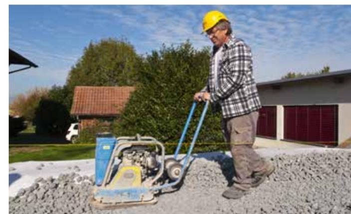
Pour le compactage, on utilise des plaques vibrantes légères de 80 à 120 kg d'une fréquence de 85 à 100 Hz. Largeur de travail ≤ 50 cm, rouleau à deux roues ou rouleau lisse (environ 1,5 t).
