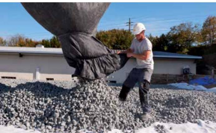
Le matériau peut être déversé directement sur le sol de fondation ou encore sur des «bâches de déversement» que l'on place tout simplement à l'arrière du camion, où elles sont ensuite remplies.
