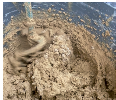
Utiliser les granulats pour créer un nouveau mélange d'enduit
