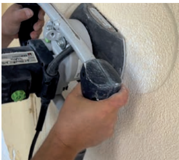
Enlever l'enduit à l'aide d'une fraiseuse
