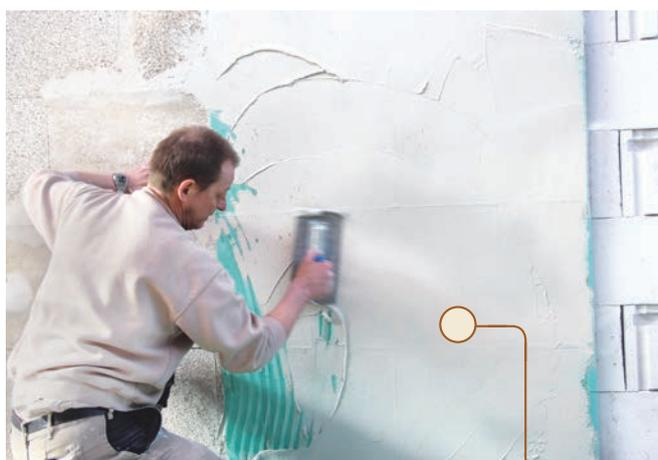
Un tissu stabilisant est collé aux plaques Liquid Pore® avec du mortier colle minéral. La surface peut ensuite être facilement lissée à l'aide d'une spatule.
