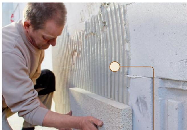
Les plaques Liquid Pore® peuvent être facilement appliquées sur toute la surface du mur à l'aide du mortier colle minéral. La base minérale permet une construction perméable à la diffusion. La façade peut ainsi « respirer » et l'atmosphère de l'habitat en est sensiblement amélioré.
